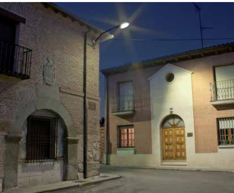
Empresa instaladora, Electricidad Olmedo.
